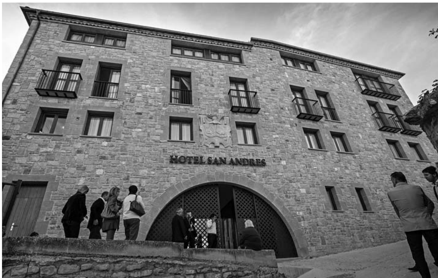
Fachada del Hostal Rural San Andrés de Torres del Río, un alojamiento que ha costado más de un millón de euros.
